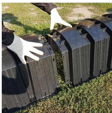
8. Połączyć tunele.
